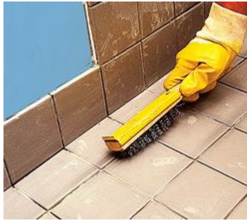
11. После полного высыхания клея швы очистим щеткой
