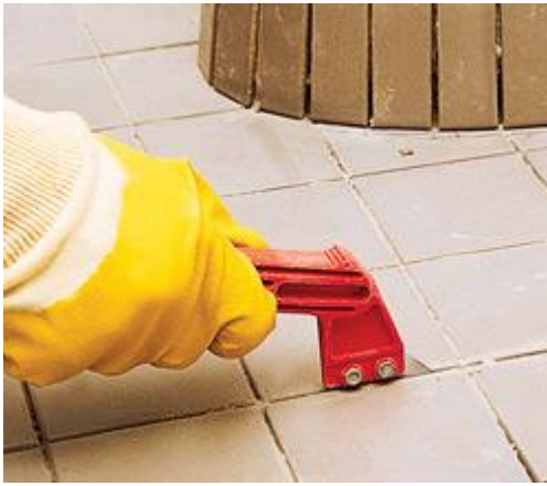
10. Скребок удаляем из швов излишки клея
