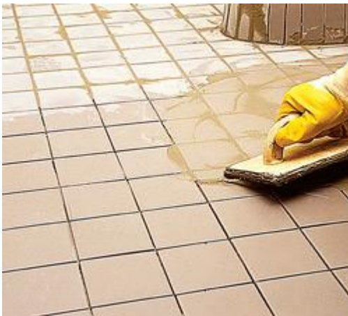
12. Резиновой теркой втираем между плитками затирочную массу
