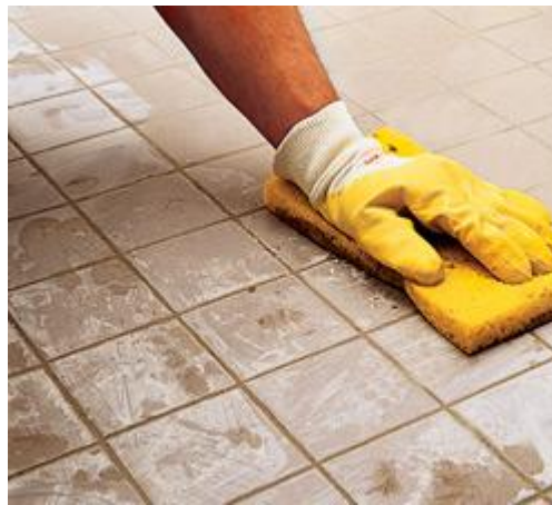
Губкой удаляем излишки затирочной массы и после ее высыхания промываем пол водой
